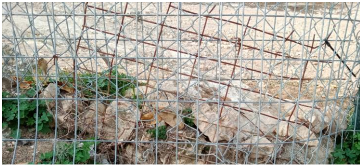
Befestigung unterhalb vom Zaun eingebrochen
