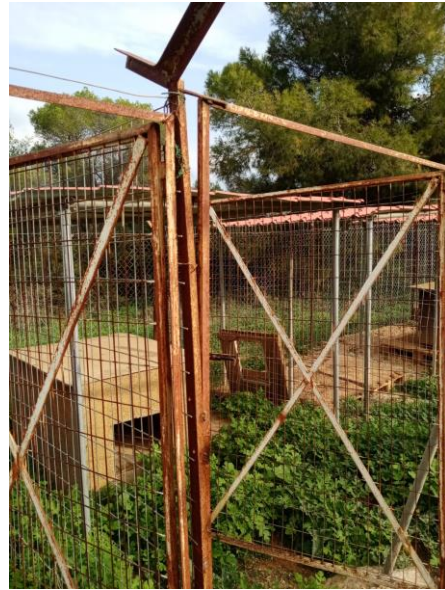
Defekte Türen Zwinger kann nicht mehr benutzt werden
